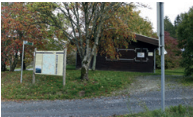
An dieser Stelle ist die neue Rettungswache geplant. | Foto: evk
