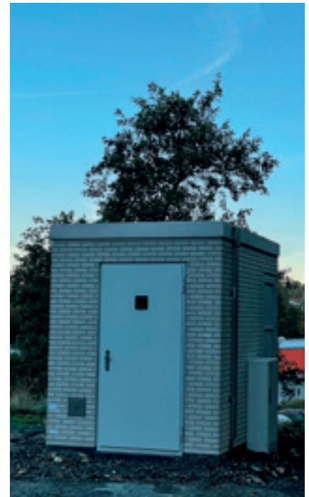
Der Hauptverteiler in Niederreifenberg steht. | Foto: jk
