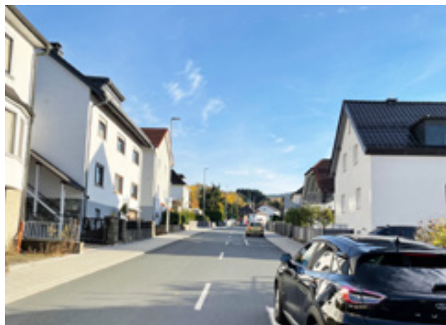
Die Ortsdurchfahrt Niederreifenberg ist bereits seit einiger Zeit fertig. Es wurden versetzte Parkbuchten angelegt, was den Effekt der Verkehrsberuhigung hat. | Fotos: gs
