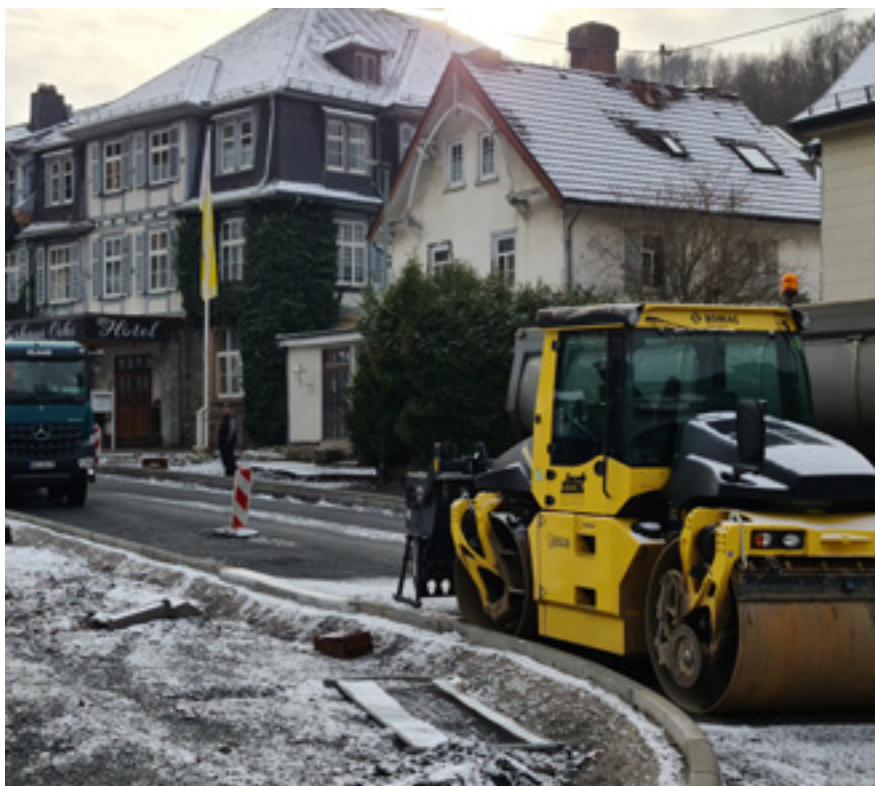
In der Kanonenstraße wird bereits die Teerschicht aufgebracht. Im neuen Jahr geht es an die Gehweganlagen. | Fotos: gs
