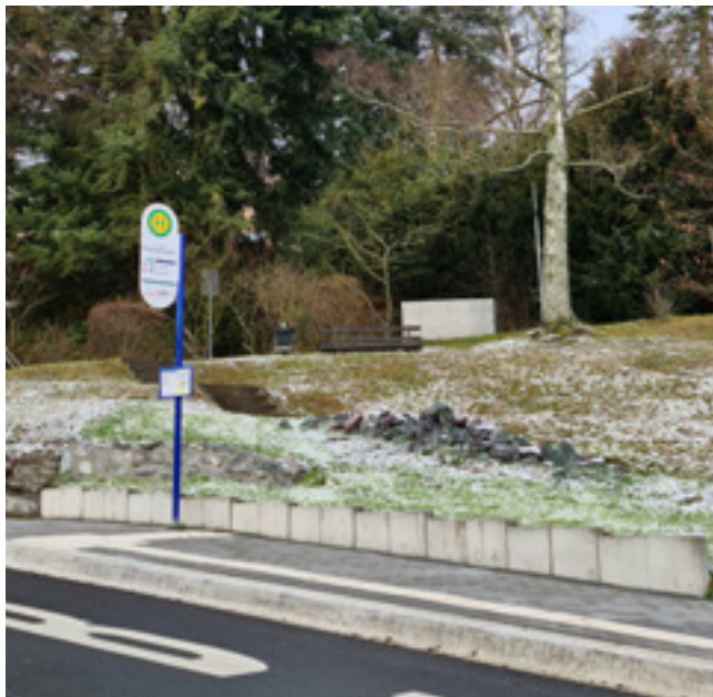
Die neue barrierefreie Bushaltestelle in der Seelenberger Straße ist bereits fertig | Foto: at
