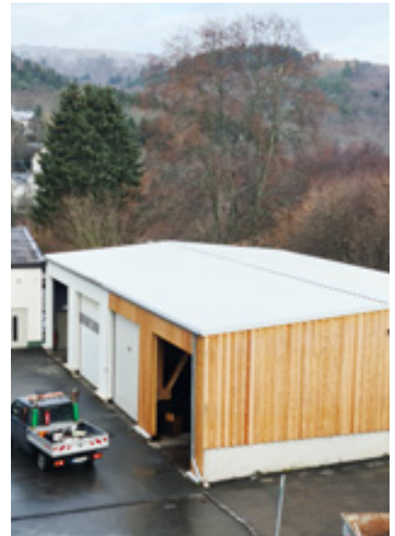
In der 2021 sanierten Salzlagerhalle lagern 170 Tonnen Salz. | Foto: gs
