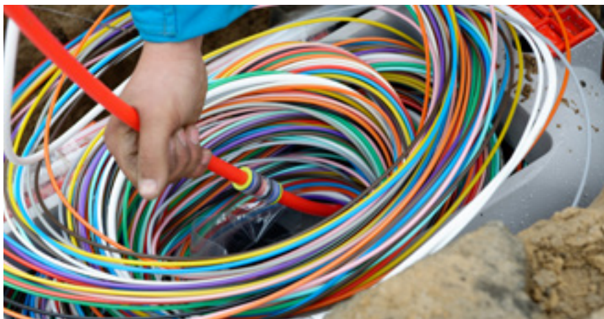
Jeder Anschlussnehmer bekommt sein eigenes Kabel, bis ins Haus. | Foto: dg
