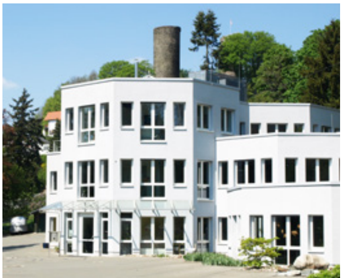
Imposante Erscheinung: Der Montessori-Kindergarten.
