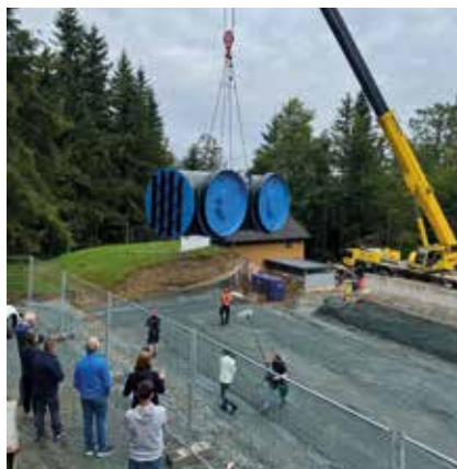
Anlieferung am 23. Juli per Großraumtransport mit fünf LKWs. Der erste wird abgeladen. | Foto: gs
