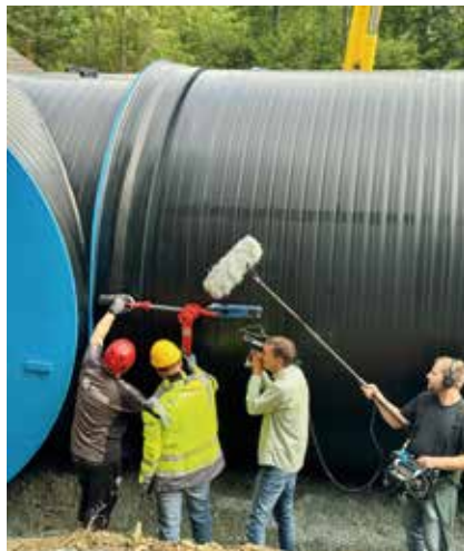
Präzisionsarbeit: Die einzelnen Elemente mussten exakt platziert werden. | Foto: gs
