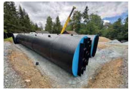
Fertig! 400 Kubikmeter fasst die Erweiterung des Hochbehälters. | Foto: gs
