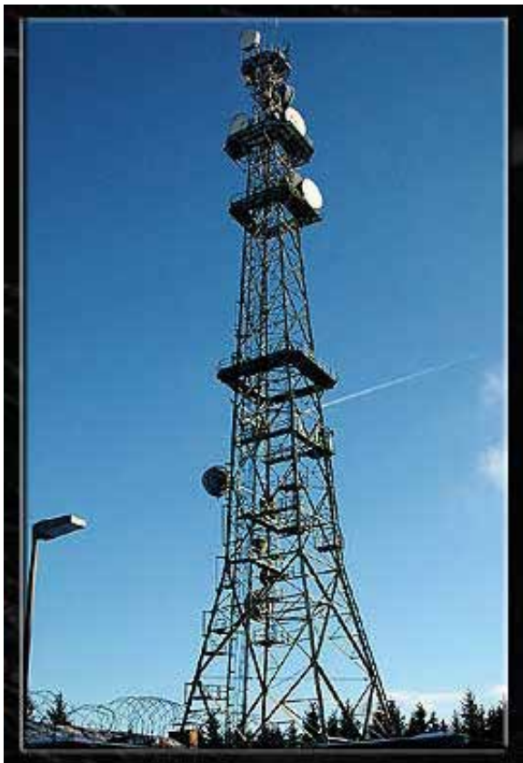
Ehemalige US-Funkstation am Sandplacken, bereitgestellt von Cold-War.de und Fulda-Gap.de | Foto: Harry Parrott, Ray Majewski, Pat Souders, Greg Lazaga, Harald Fäth
