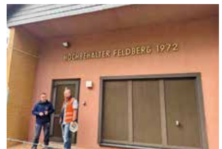
Der bestehende Hochbehälter Feldberg fasste lediglich 300 Kubikmeter und wurde nun um weiter 400 Kubikmeter erweitert. | Foto: gs
