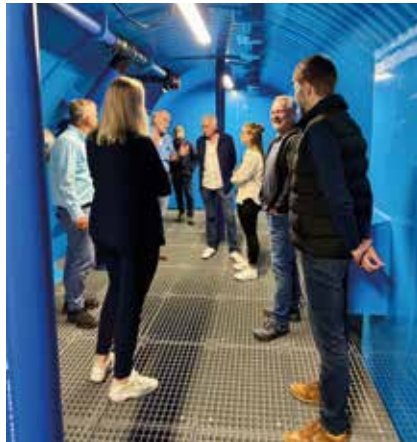
Abnahme im Werk der Firma Frank Kunststofftechnik GmbH in Wölfersheim am 16. Juli. | Foto: gs
