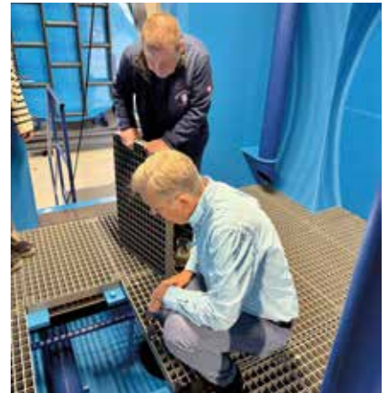
Der Wassermeister prüft kritisch ob alles korrekt vorbereitet ist. | Foto: gs
