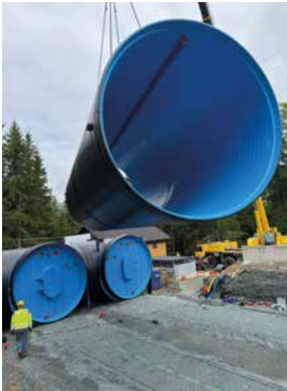
Eine der Röhren wird abgeladen und platziert. Sie fasst allein 100 Kubikmeter Wasser. | Foto: gs
