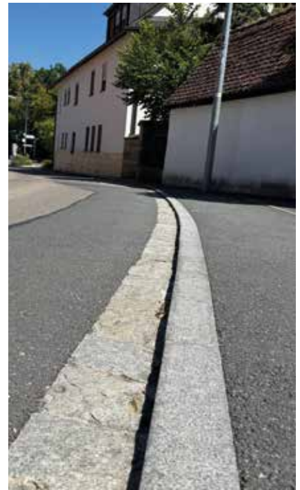
Bei dieser Straße in Rednitzhembach war der Ausgangszustand und der Unterbau so gut, dass nur die Asphaltschicht erneuert werden musste. | Foto: gs
