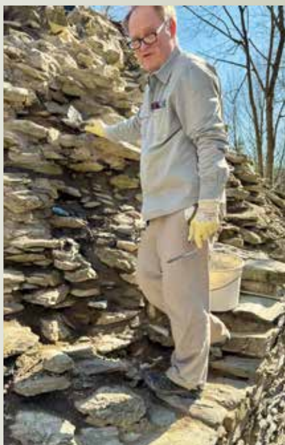
Ein ehrenamtlicher Helfer saniert und sichert einen Teil der Mauer rechts vom Eingang zur Burg. | Foto: jk
