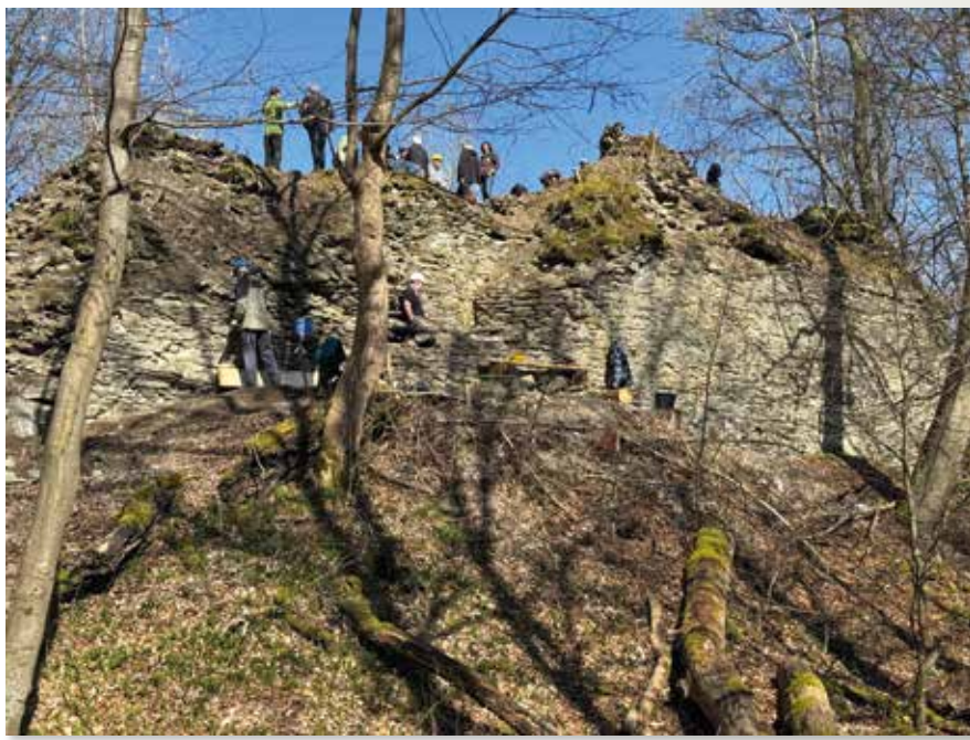
Nach den Arbeiten im September 2024 ist nach einer weiteren Arbeitswoche im März 2025 nun vom Wanderweg die Burgmauer wieder deutlich zu erkennen. | Foto: jk
