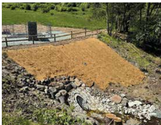
Die neue Bachverrohrung des Krötenbachs mit der umgestalteten Grünecke in Arnoldshain. | Foto: gs
