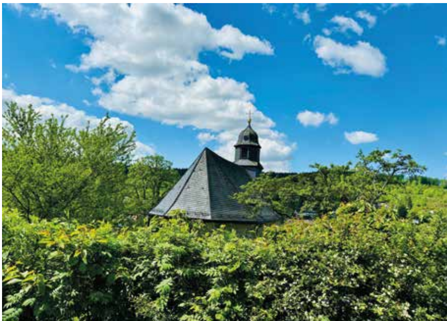
Die Laurentiuskirche Arnoldshain wird mit einer Beschallungsanlage ausgestattet. | Foto: gis
