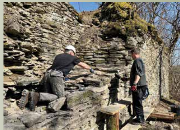
Alle ehrenamtlichen Helfer haben viel Erfahrung in der behutsamen Sanierung von alten Burgen. | Foto: jk
