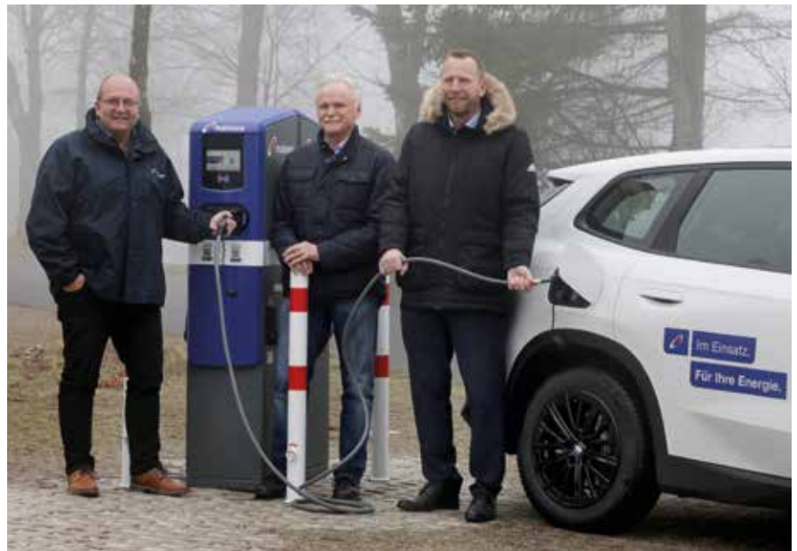
Schmittens Erster Beigeordnete Hartmut Müller (Mitte), Lothar Stanka, Bereichsleiter Energiedienstleistungen und digitale Kundenlösungen bei Mainova, sowie Mainova-Kommunalmanager Jens Boldt, weihten die Ladesäulen am Sandplacken am 26. März offiziell ein. | Foto: Mainova
