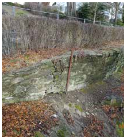
Im Frühjahr 2024 wird die Stützmauer saniert. | Foto: mh
