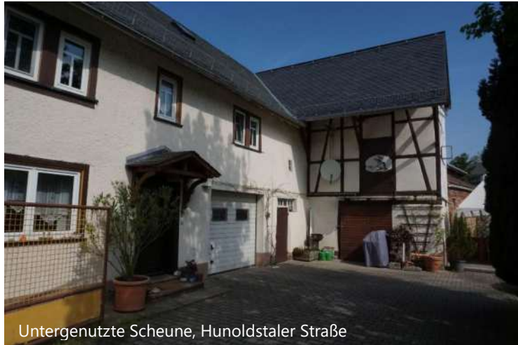
Abbildung 102: Impressionen zu Baustruktur und -potenzialen in Treisberg
