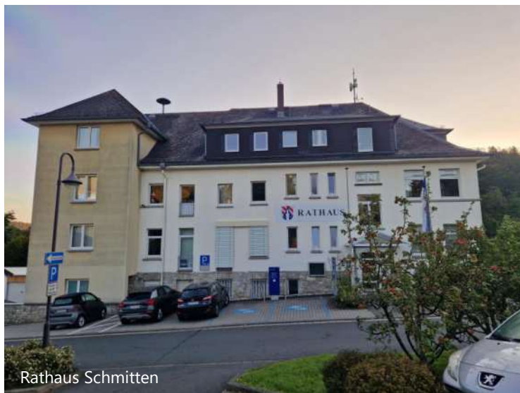
Abbildung 88: Impressionen zu Baustruktur und -potenzialen in Schmitten
