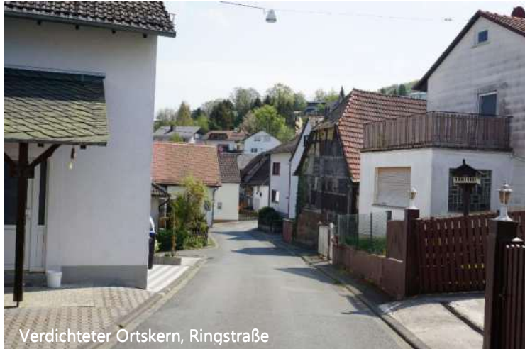
Abbildung 58: Impressionen zu Baustruktur und -potenzialen in Dorfweil
