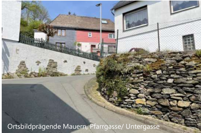
Abbildung 80: Impressionen zu Baustruktur und -potenzialen in Oberreifenberg
