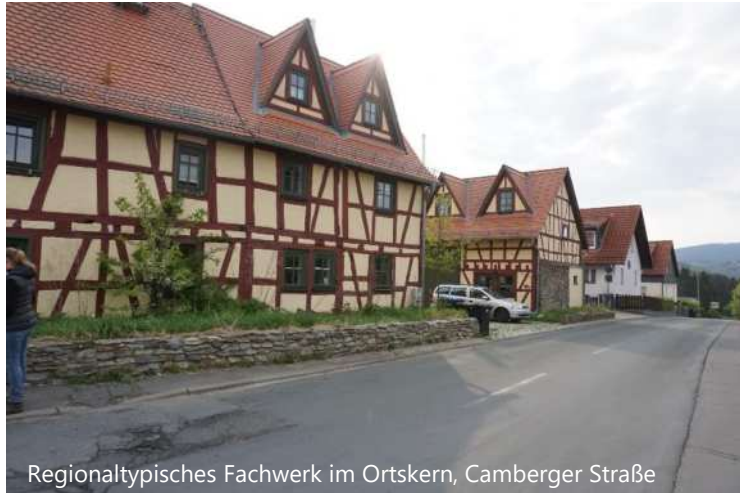
Abbildung 95: Impressionen zu Baustruktur und -potenzialen in Seelenberg
