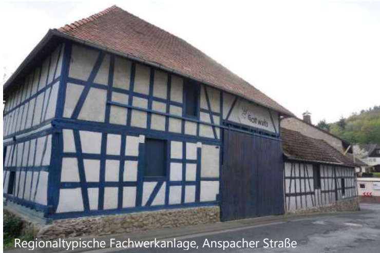
Abbildung 66: Impressionen zu Baustruktur und -potenzialen in Hunoldstal
