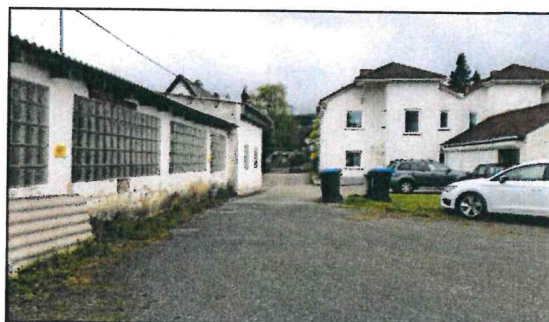
Abb. 2: Blick entlang der geschotterten und gepflasterten Flächen Richtung Süden.
