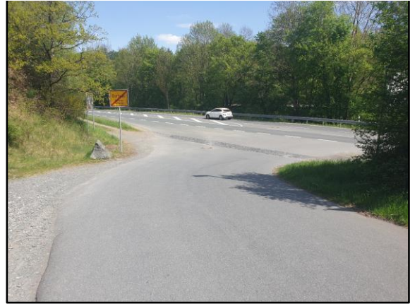
Abb. 14: Auffahrt von der Landesstraße auf den Triebweg
