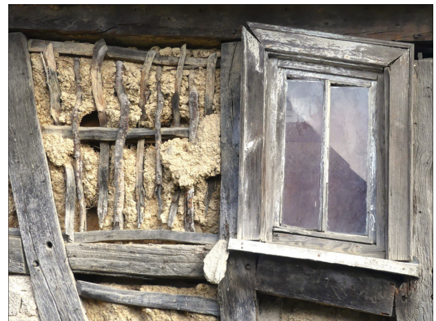
Abb. oben links: Bauzeitlicher Lehmunterputz, Trauffassade Rückseite Abb. oben rechts: Kalkputz mit Drahtarmierung, Trauffassade Straßenseite Abb. unten links: Ansicht von Südwesten Abb. unten rechts: Bauzeitliches Fenster, Trauffassade Rückseite
