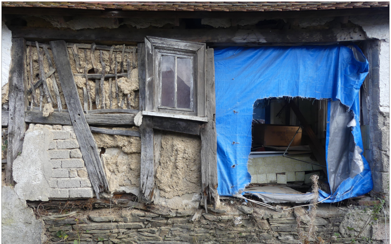
Abb. oben: Traufwand nach Westen, südlicher Abschnitt
